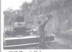
▲破碎機への投入
